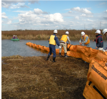
オレンジ色のものがオイルフェンスです。 写真は船で引っ張って対岸へ伸ばしている様子を写しています。
