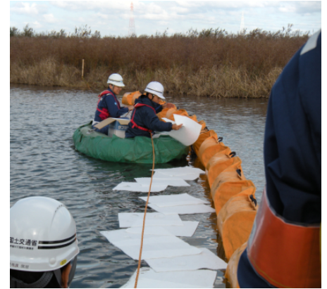
水に浮いている白いものがオイルマットです。これで油を吸い取ります。 写真のタイプのほかに、万国旗のようにつながっているものもあります。
