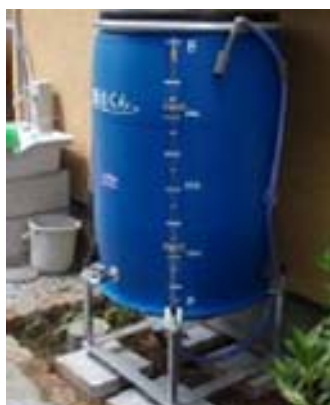
家庭用の雨水貯留タンク
