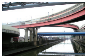
① 新加平橋から嘉兵衛新田(西加平)と綾瀬川右岸上流を望む
