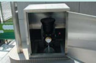
ポンプ非常停止時に発生する水圧の変動を調節するサージタンクを4箇所に設置し、導水管の損傷を防ぎます。
