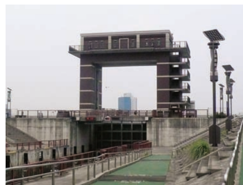
荒川ロックゲート
