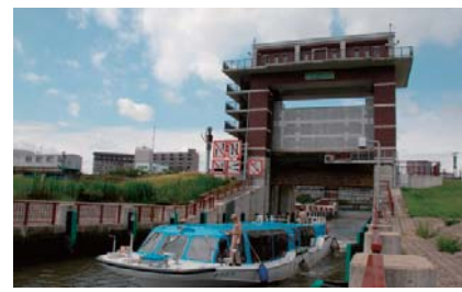
荒川ロックゲート
