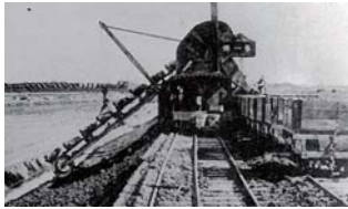
機械掘削の様子
