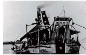
機械浚渫の様子
