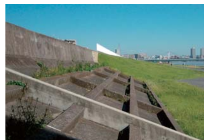
荒川の高潮堤防
