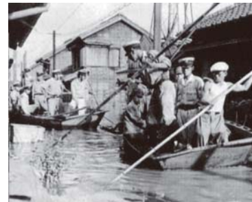
カスリーン台風による被害 (出典：荒川下流誌)
