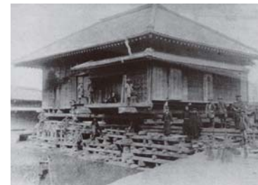
移転のための曳屋
