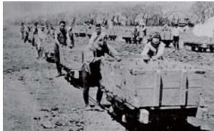
人力掘削の様子
