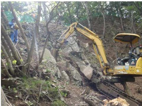
図7 法面整形工（SSD工法）
