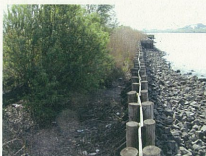
写真 1.3.4 板柵工タイプ (板橋区新河岸地先)
