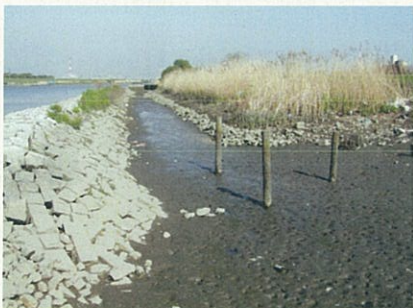
写真 1.3.3 捨石工タイプ (板橋区新河岸地先)
