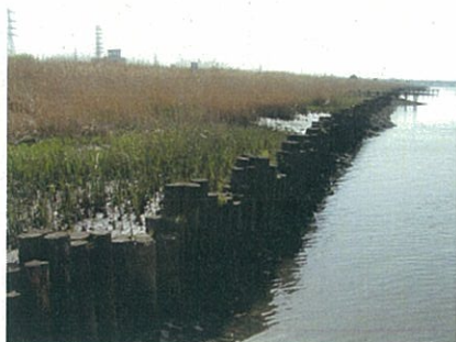
写真 1.3.1 柱列杭工タイプ (板橋区新河岸地先)
