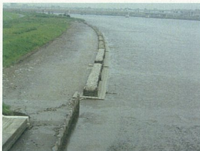
写真 1.3.2 木工沈床工タイプ (江戸川区小松川地先)
