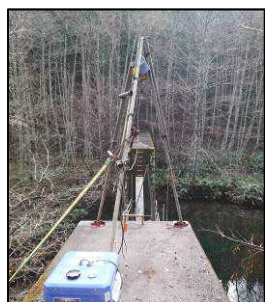
写真-12 ウィンチの設置状況
