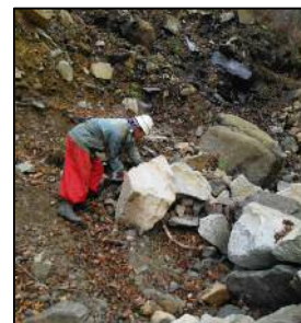
写真-10 浮石除去状況
