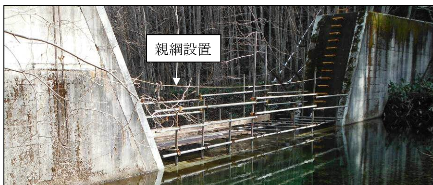
写真－4 水通し上の足場状況
