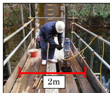
写真-7 軽量ボーリング作業状況
