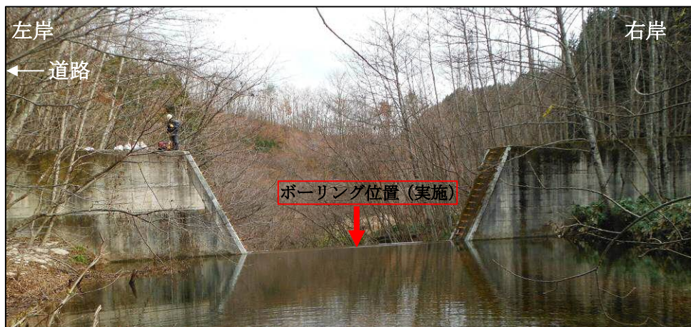
写真－2 堆砂後の状況（上流から撮影）
