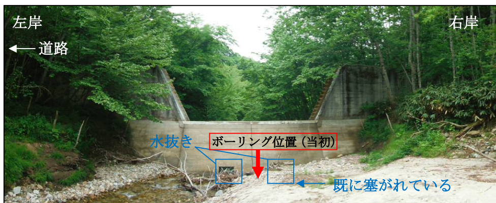
写真－1 堆砂前の状況（上流から撮影）
