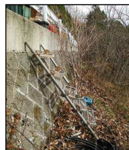
写真-13 梯子の設置状況
