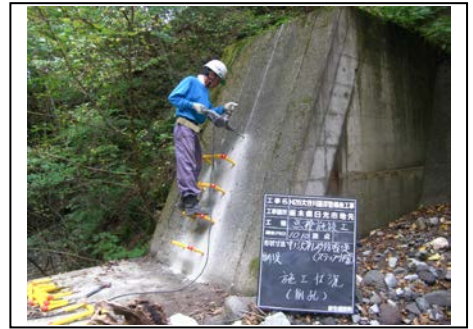
ステップ設置施工状況
