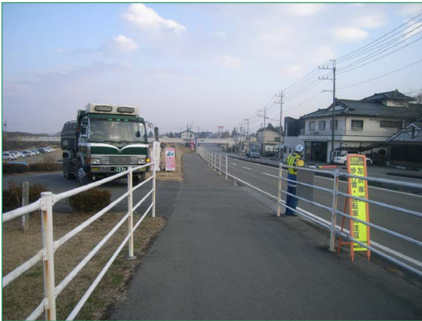
工事用車両出入り口 ランプ・警報器および交通誘導員併用による工事車両誘導状況
