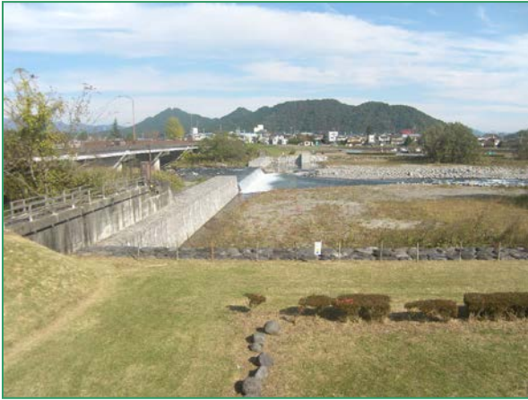
今市下流床固工 右岸側より撮影
