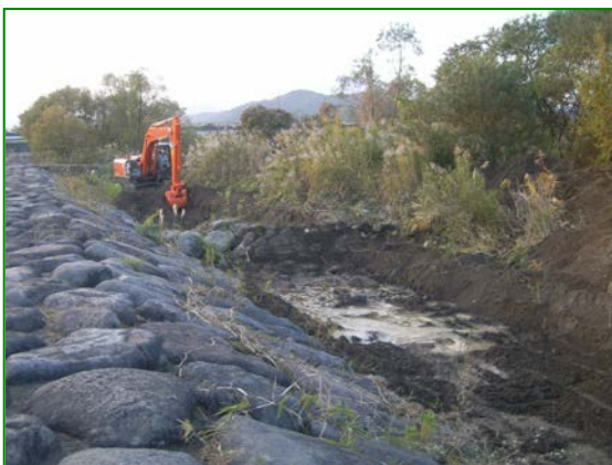
点検用の水路整備状況
