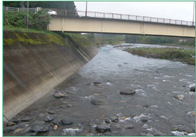
町谷既設護岸工 下流より撮影
