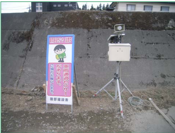
工事用車両出入り口 車両通過センサー設置状況
