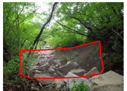
落石防護ネット設置状況
