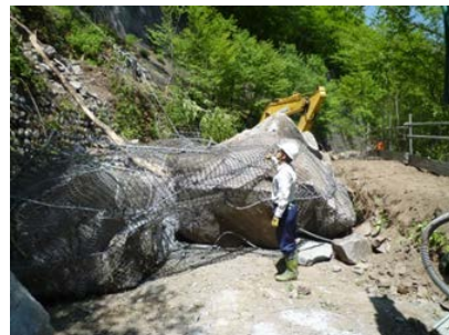
崩落発生箇所確認
