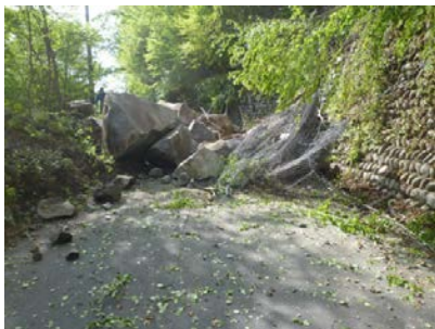
工事用道路(終点側)
