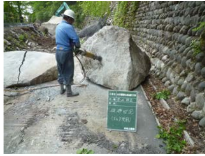
破砕状況(ダルダ使用)
