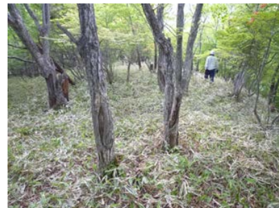
崩落箇所上部
