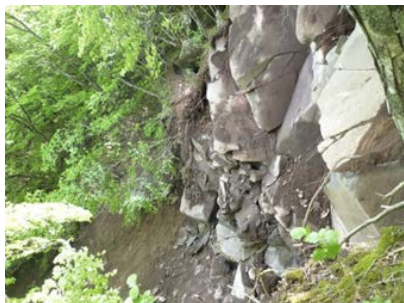
崩落発生箇所
