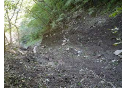
2回目の崩落後
