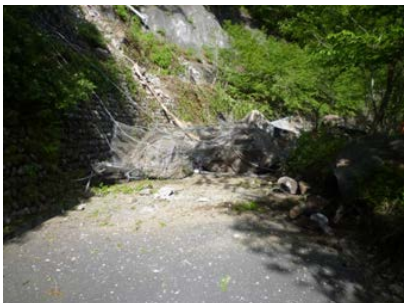
工事用道路(起点側)
