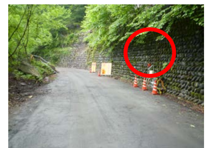
落石センサー設置状況
