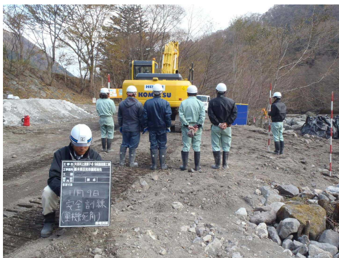
(重機死角の確認)
