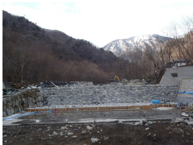
(第7床固め 全景)
