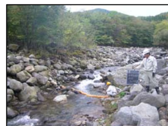
(オイルフェンスの設置)
