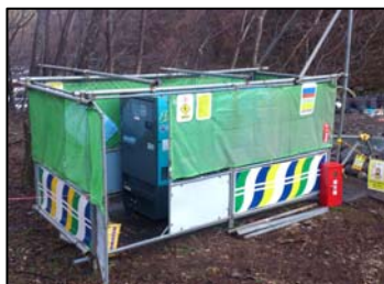
(発電機設置状況)
