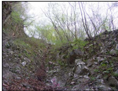
頂上部付近の露岩崩壊部
