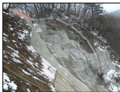
ビニールダクト設置状況
