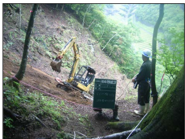
無人化施工状況
