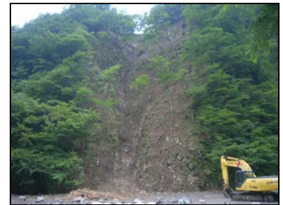
施工箇所全体(伐採完了後)
