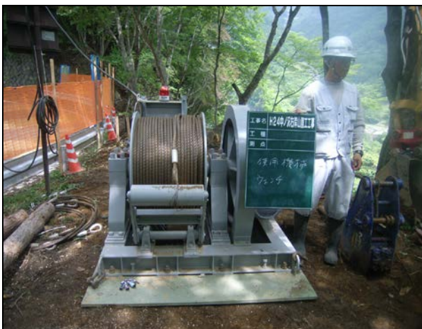
ウィンチ設置状況
