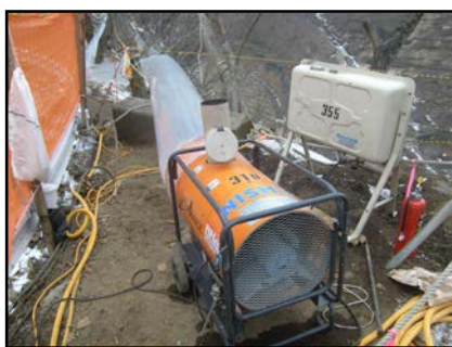
ジェットヒーター設置状況
