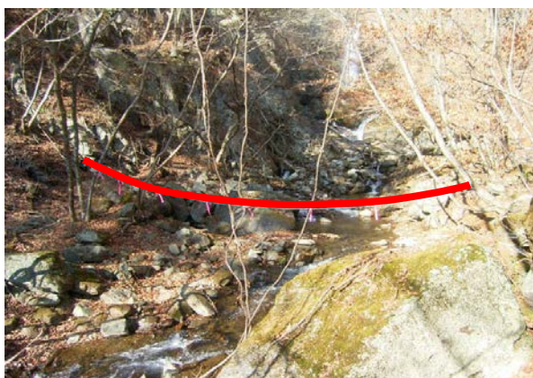
土石流感知装置の設置
