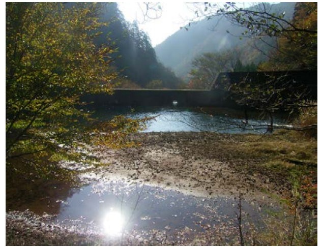
田母沢上流堰堤上流
