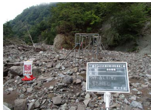
ビティ足場による緊急通路設置
