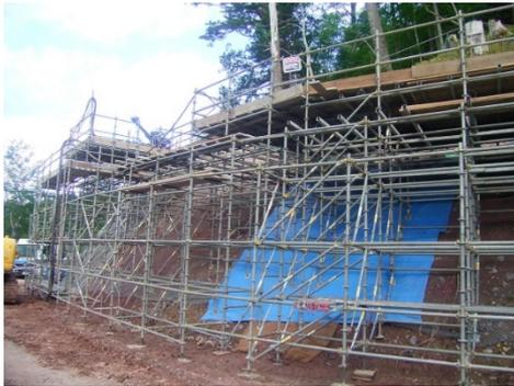
図 - 8 アンカー工作業構台全景
