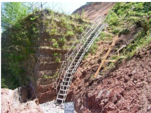
図 - 12 作業構台昇降設備
