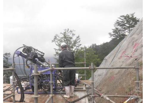
3. 2 法面の昇降設備は、設置角度を自在に変えられる手摺付きステップ「法面 2 号ユニバーサルユニット自在階段」にすることで、歩き易くなり安全性の向上を図りました。
