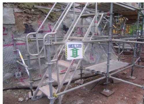
3. 3 法面施工時の転落・墜落防止対策としては、親綱の養生に保護カバーを用い併用してセーフティーブロックを使用し2重の安全対策を施して、安全性の向上を図りました。
