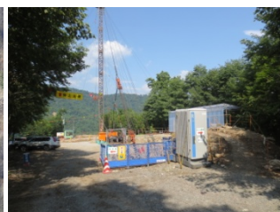
ケーブルクレーン 2.5t 吊 全景
