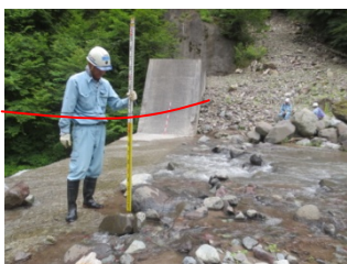
土石流センサー（第3砂防堰堤）
