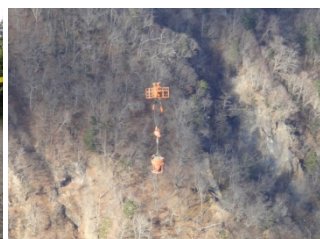
生コンクリート吊作業中
