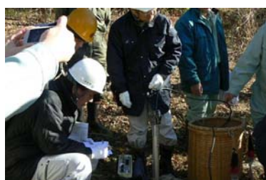
観測機器(傾斜計)計測訓練 (利根川水系砂防事務所)
