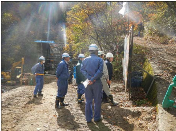
H24持丸沢第3砂防堰堤改築工事の安全点検状況
