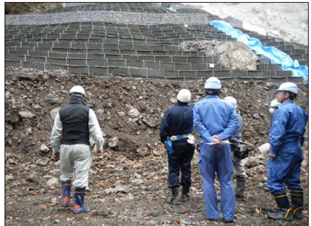
野門沢山腹工工事の安全点検状況
