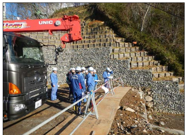
H23大事沢第5砂防堰堤工事の安全点検状況
