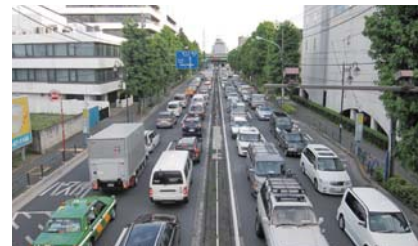
環状8号線（杉並区高井戸東2丁目付近）
