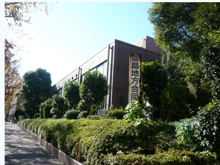
豊島地方合同庁舎(既存)
