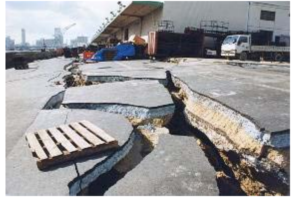
【阪神・淡路大震災時の港湾施設の被災状況】
