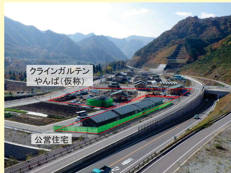
公営住宅・クラインガルテンやんば(仮称) (整備中)
