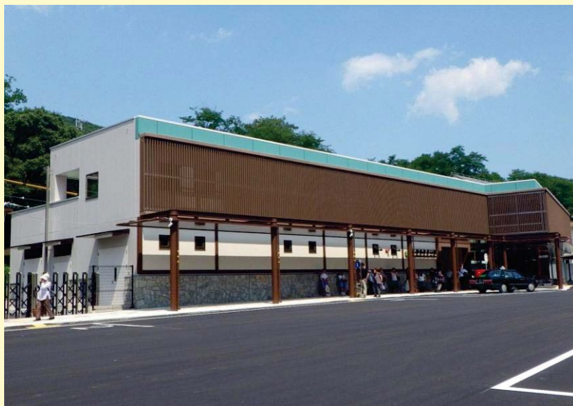
JR長野原草津口駅新駅舎開業(H25.8.1)
