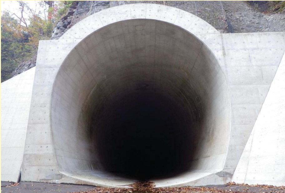
仮排水トンネル
