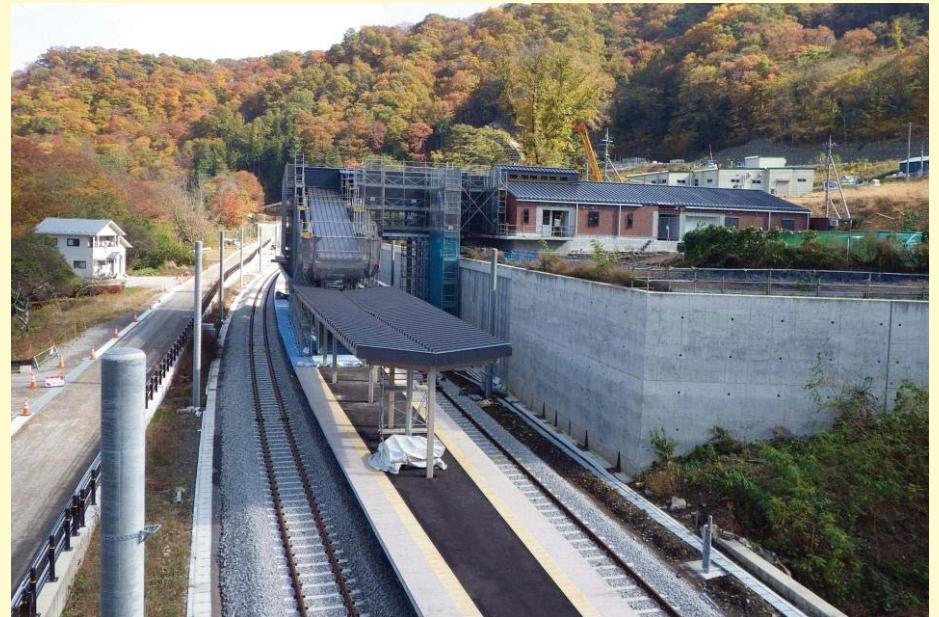
付替鉄道(川原湯温泉駅(新駅))
