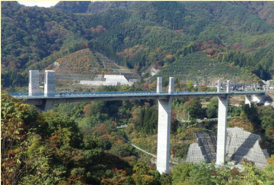
付替県道(湖面1号橋)
