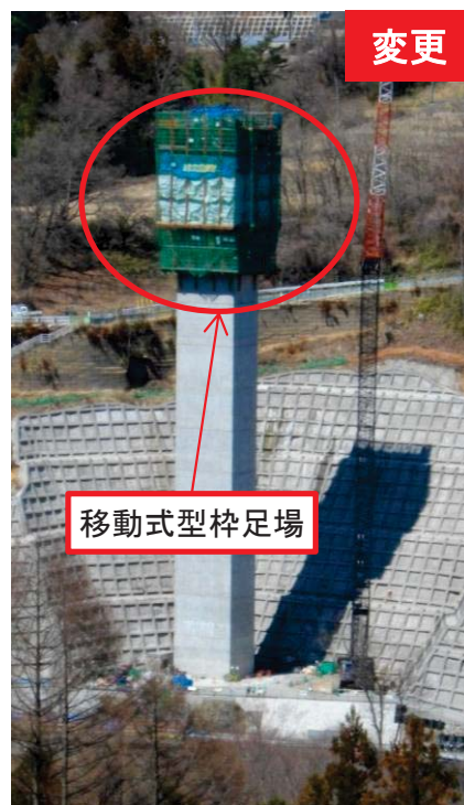
移動式型枠足場
