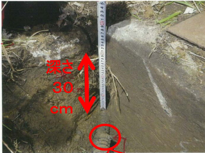
バックホウで配管を引き上げた
