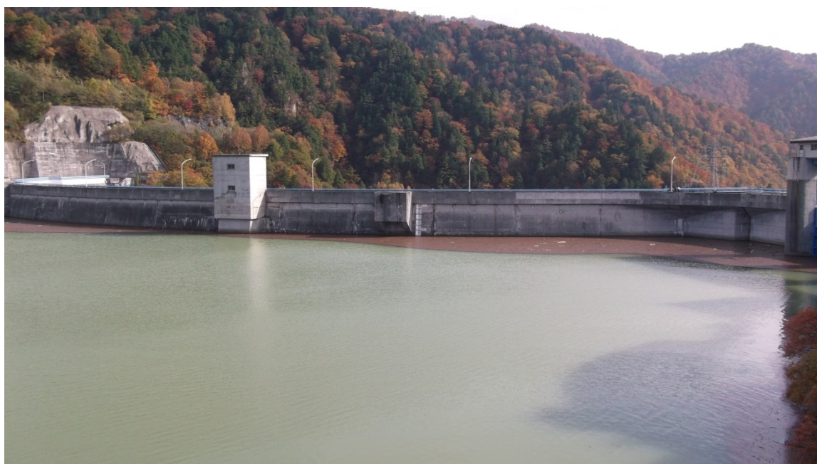
写真：矢木沢ダム (撮影日 10月29日)
