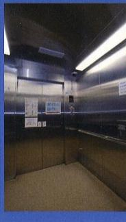
ダム堤体内部には2基のエレベーターが設置されており、放流設備などの機器の交換や、点検等の維持管理に利用されています。そのうち1基のエレベータは、ダムの体験学習を目的として一般見学者も利用できます。
