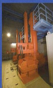
高位常用洪水吐設備はダム堤体を上下流方向に貫通する二本の放流管路の途中にあります。ダム水圧に耐えられる頑丈なステンレス鋼の扉が油圧によって上下に動き、管路内の水を流したり止めたりしています。
