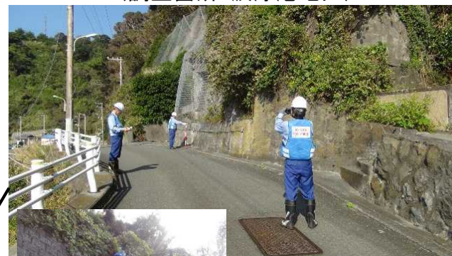
①B: 急傾斜地の施設点検 (調査箇所: 波浮港地区)
