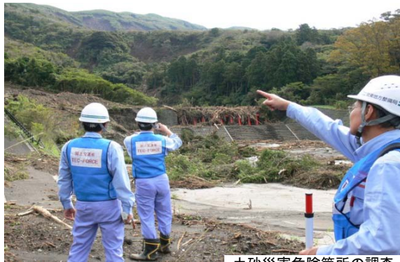
土砂災害危険箇所の調査
