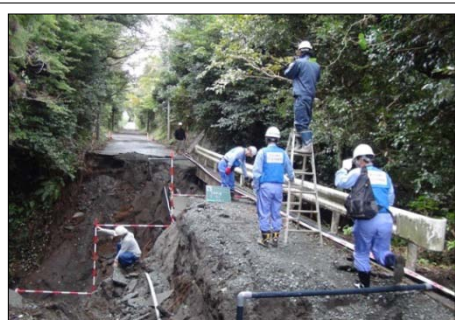
道路被災箇所調査
