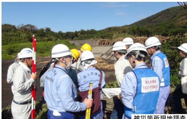
被災箇所現地調査
