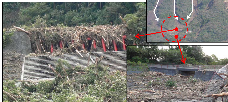
大金沢支川堆積工
