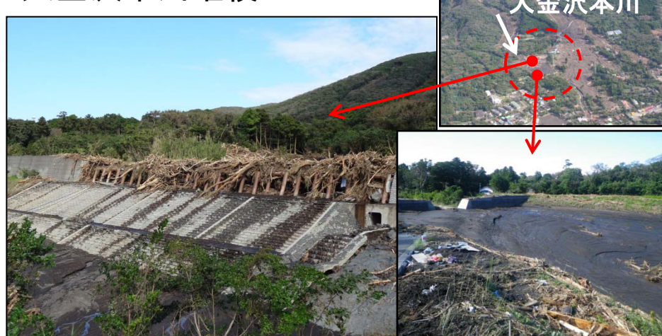
大金沢本川堆積工
