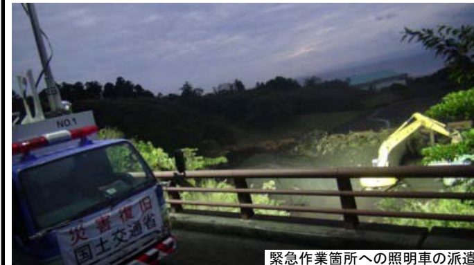
緊急作業箇所への照明車の派遣
