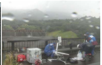
監視カメラの設置
