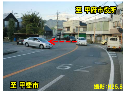
写真② 線形が悪いため、沿道からの合流車両が見えにくく、危険な自動車
