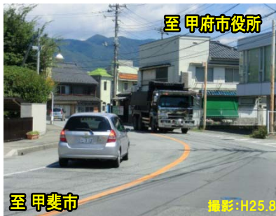
写真① 見通しがきかない線形不良箇所
