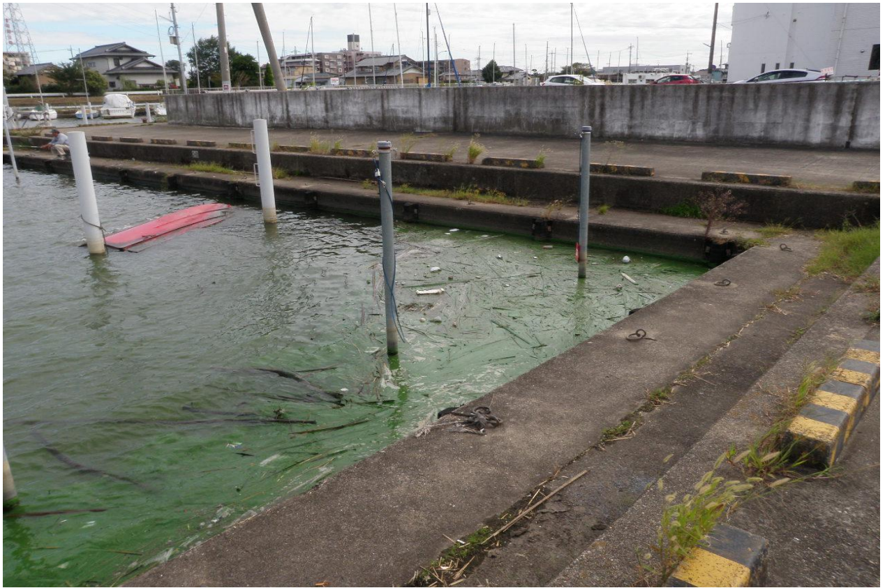
西浦中岸1.50km-150m レベル4 悪臭無し
