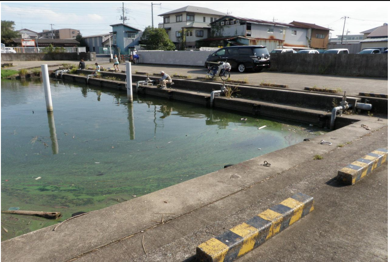
西浦中岸1.25km+200m レベル3～4 悪臭無し
