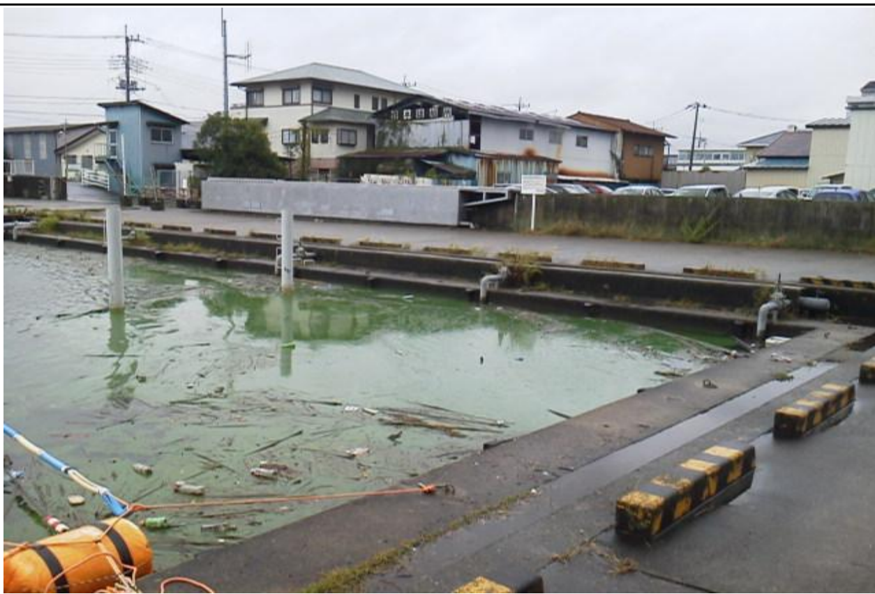
西浦中岸1.25km+200m レベル4 悪臭無し
