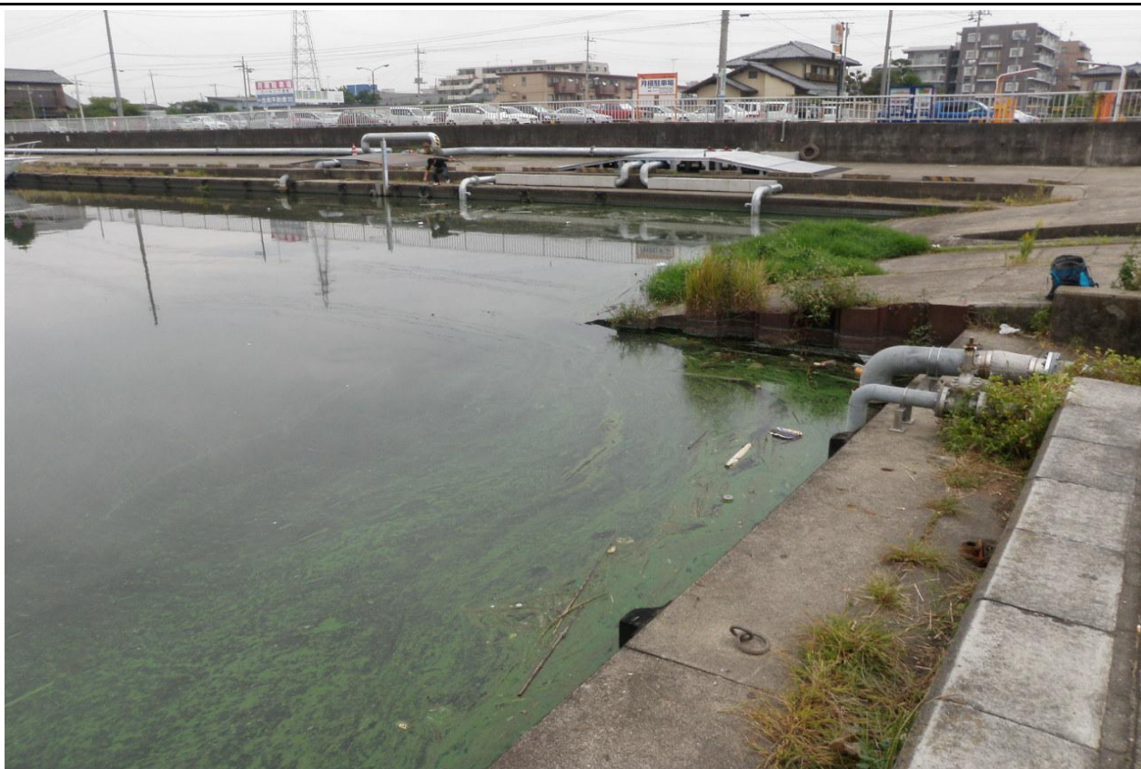
西浦中岸1.25km+150m レベル3 悪臭無し
