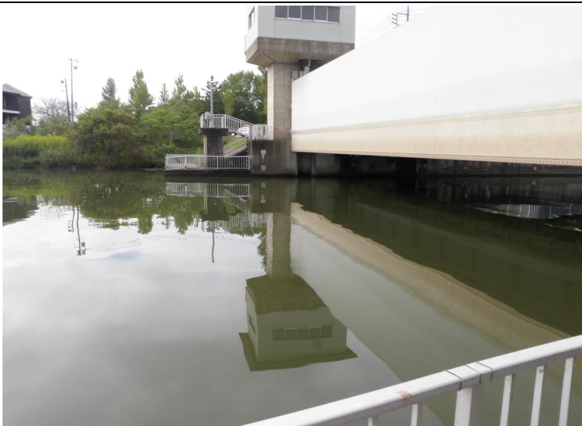
西浦右岸47.25km+50m 備前川水門前 レベル2～3 悪臭無し
