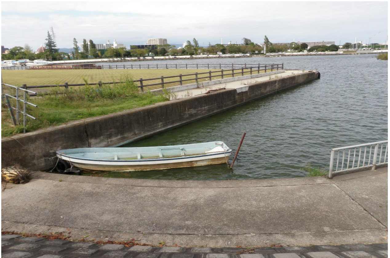
西浦中岸1.00km-50m レベル3 悪臭無し
