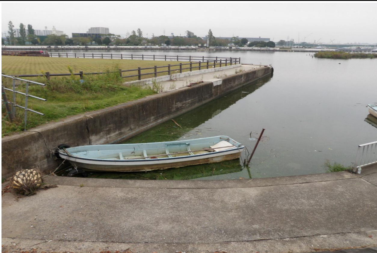
西浦中岸1.00km-50m レベル3 悪臭無し
