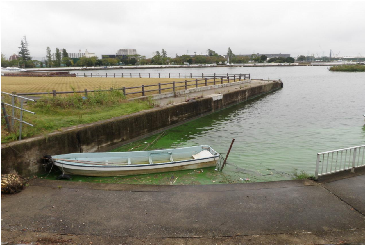
西浦中岸1.00km-50m レベル3~4 悪臭無し
