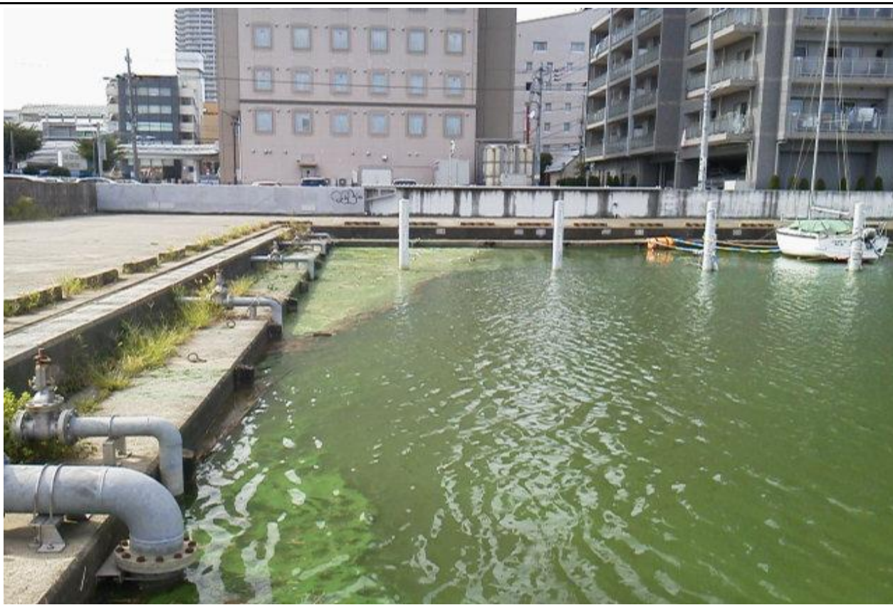
西浦中岸1.25km+200m レベル4 悪臭無し
