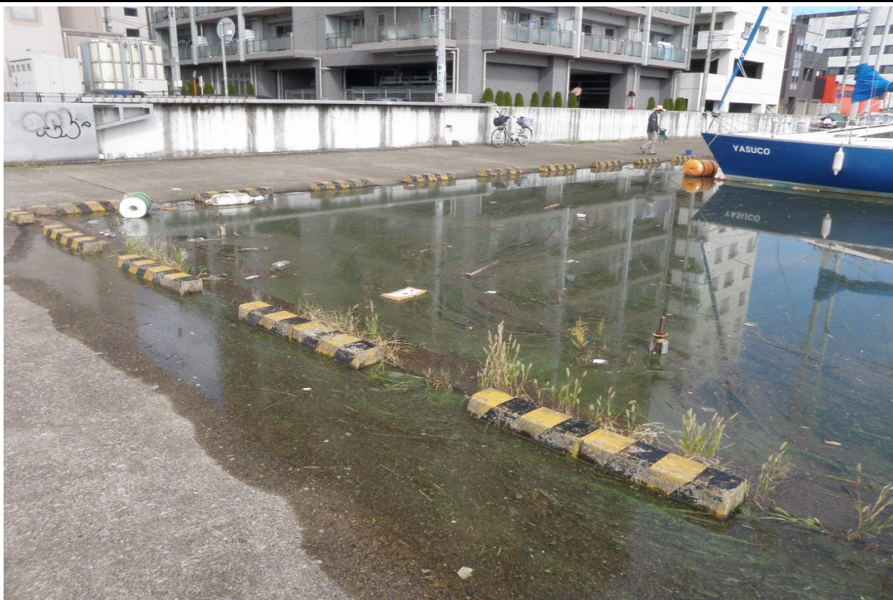
西浦中岸1.25km+200m レベル3 悪臭無し
