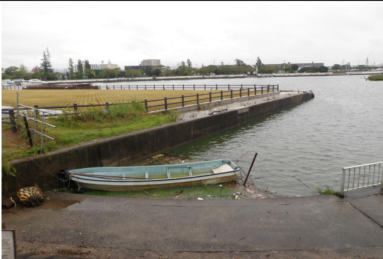
西浦中岸1.00km-50m レベル3~4 悪臭無し
