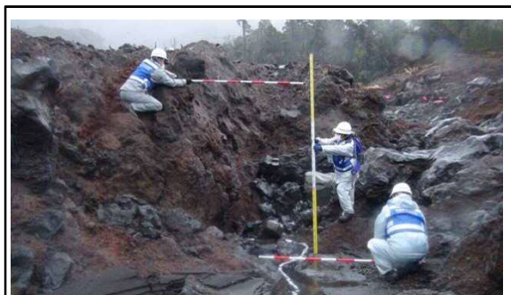
点検状況(大金沢)
