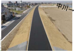
右岸中上流堤防整備
