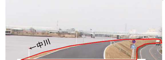
放水路区間堤防嵩上げ (綾瀬川放水路～三郷放水路)
