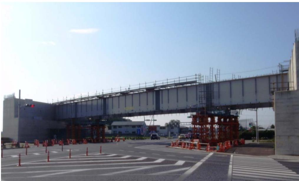
9月10日に最後のブロックを架設し、全ての橋桁の架設が完了しました。
