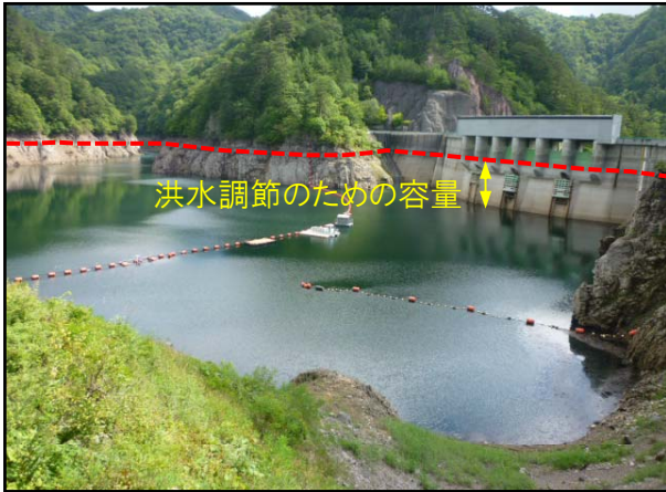
川俣ダム貯水池
