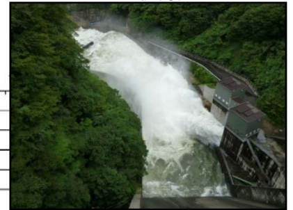
五十里ダム放流状況写真
