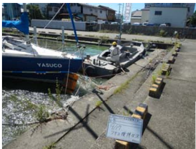
作業船によるアオコ攪拌作業①
