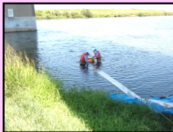
河川に排水ポンプを設置
