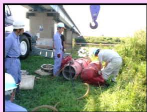
ポンプにフロート(浮袋)を取り付け、空気を注入
