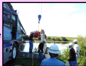
ポンプ吊り上げ (25tクレーン)
