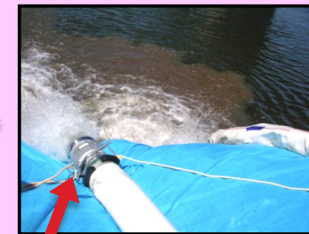
排水状況 (ホースの先端部のあばれ防止のために端末固定装置を取り付けている)
