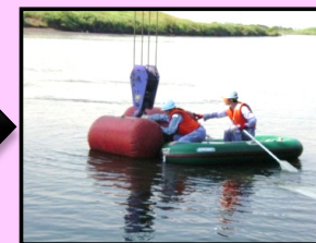
ポンプ撤去のため、ポンプにワイヤーの取り付け
