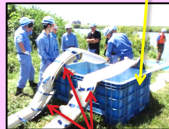
ホースに排水サポーターを設置(屈曲防止)
