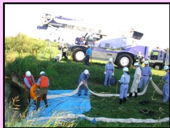
排水ポンプにホースを取り付け、河川内へ移動
