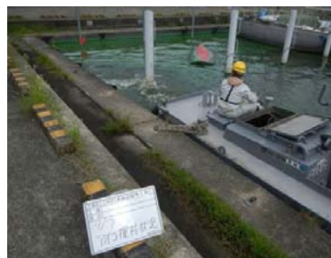
作業船によるアオコ攪拌作業②
