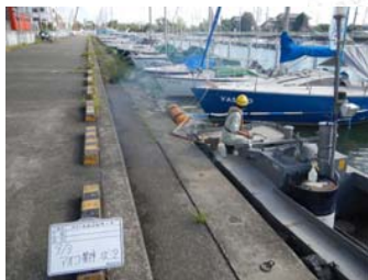
作業船によるアオコ攪拌作業①
