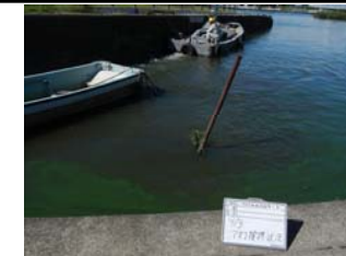
作業船によるアオコ攪拌作業⑤
