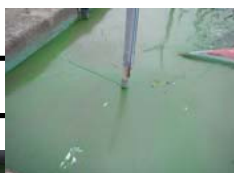
作業船によるアオコ攪拌作業②
