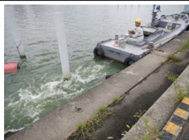
作業船によるアオコ攪拌作業②
