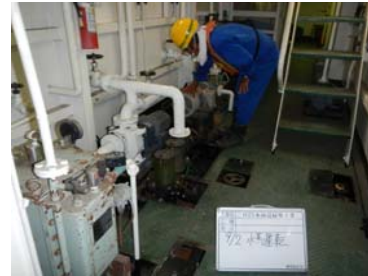
水馬運転状況①
