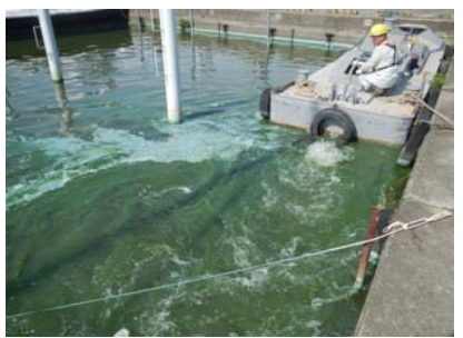
作業船によるアオコ攪拌作業①
