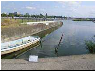
作業船によるアオコ攪拌作業①
