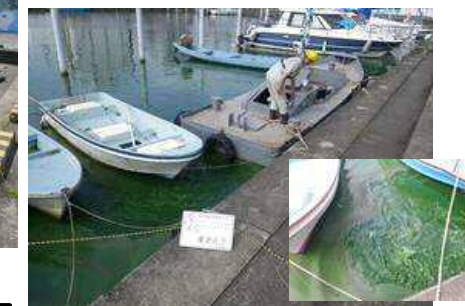
作業船によるアオコ攪拌作業③
