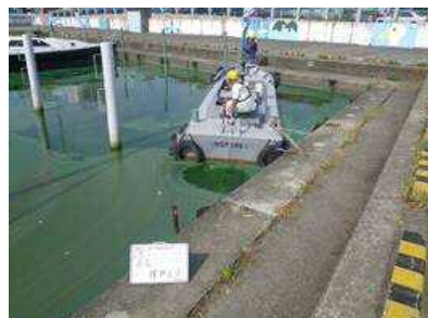
作業船によるアオコ攪拌作業②
