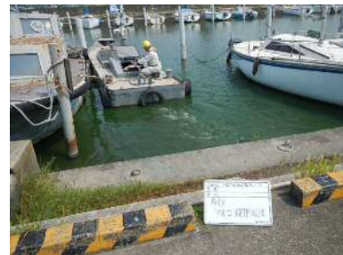
作業船によるアオコ攪拌作業②
