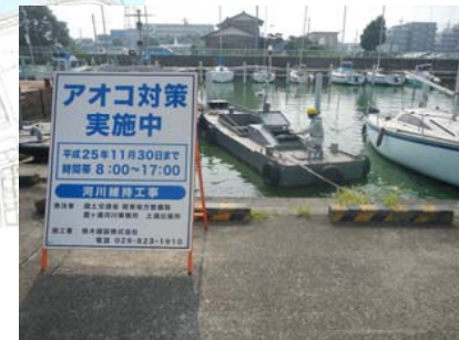
作業船によるアオコ攪拌作業①
