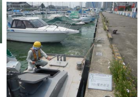
作業船によるアオコ攪拌作業②
