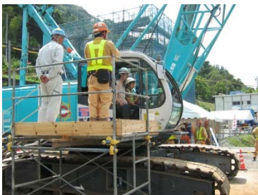
吊り上げ機械の操作
