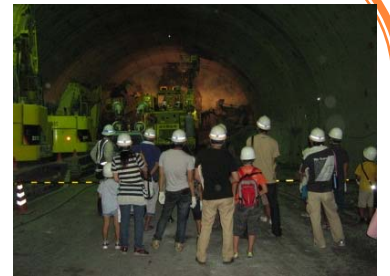
掘削箇所見学
