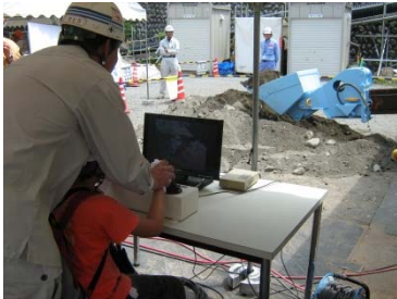
掘削機械の遠隔操作
