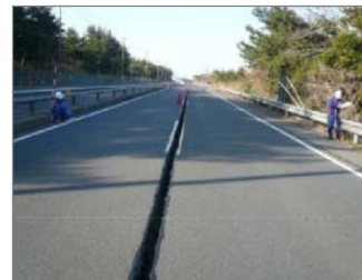
段差が発生した国道51号 大洗町成田町
