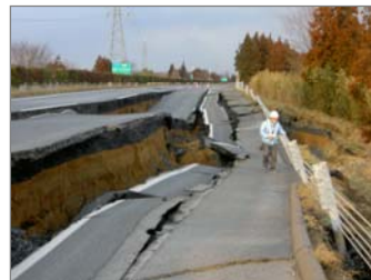
崩落した常磐自動車道 水戸IC～那珂IC付近
