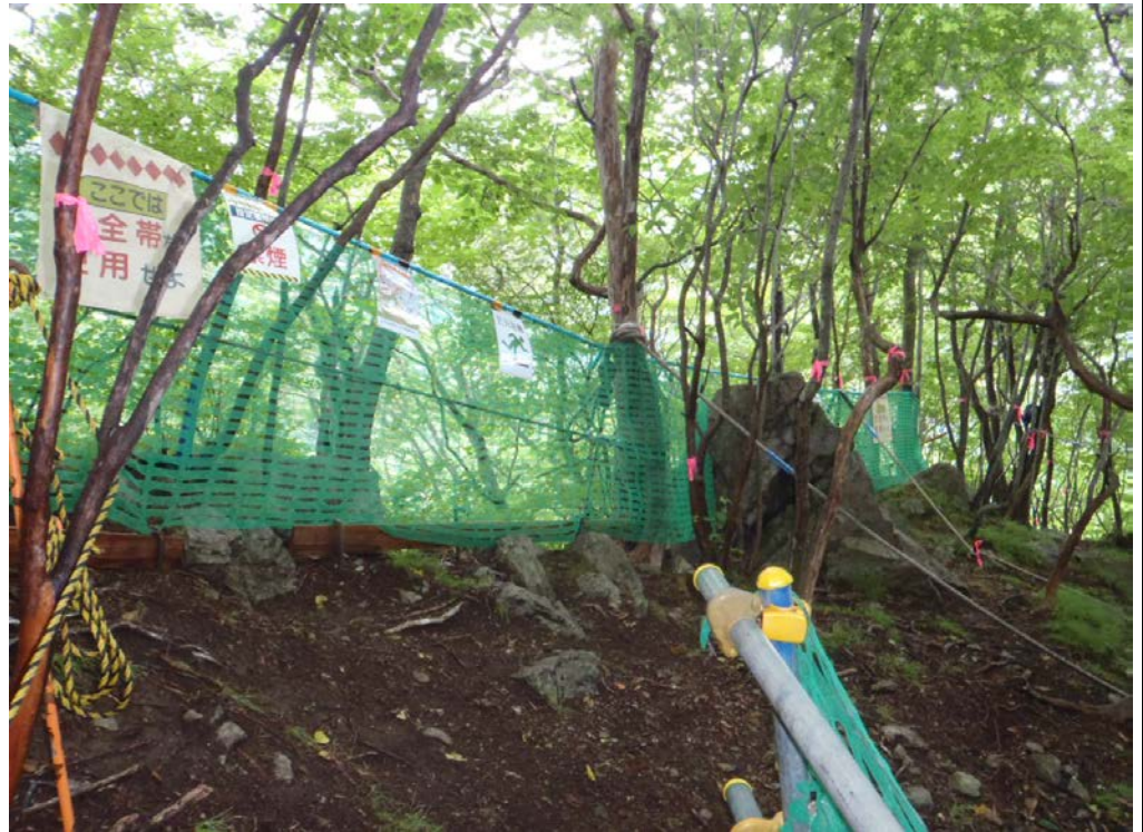
仮設工施工中
