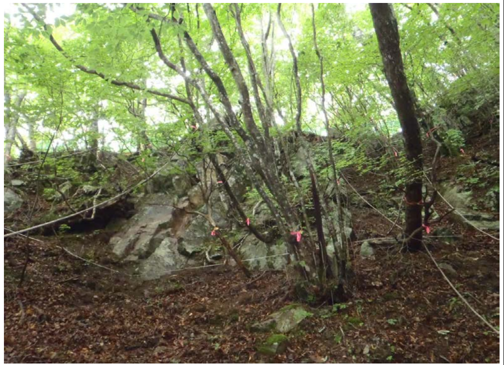
施工場所一例
