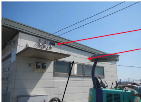
支線(電話線に負担が掛からないよう事故後に端部を屋根の上に移動)
